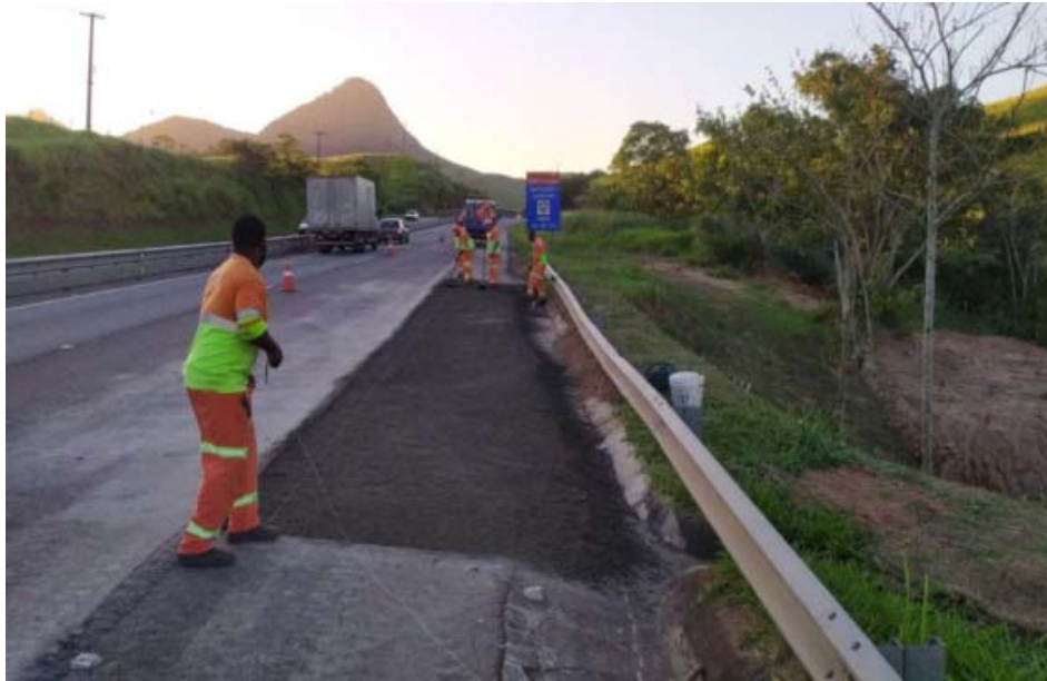
FOTO 01 - Rep. Superficial de Acostamento – Km 11+200 Sul
