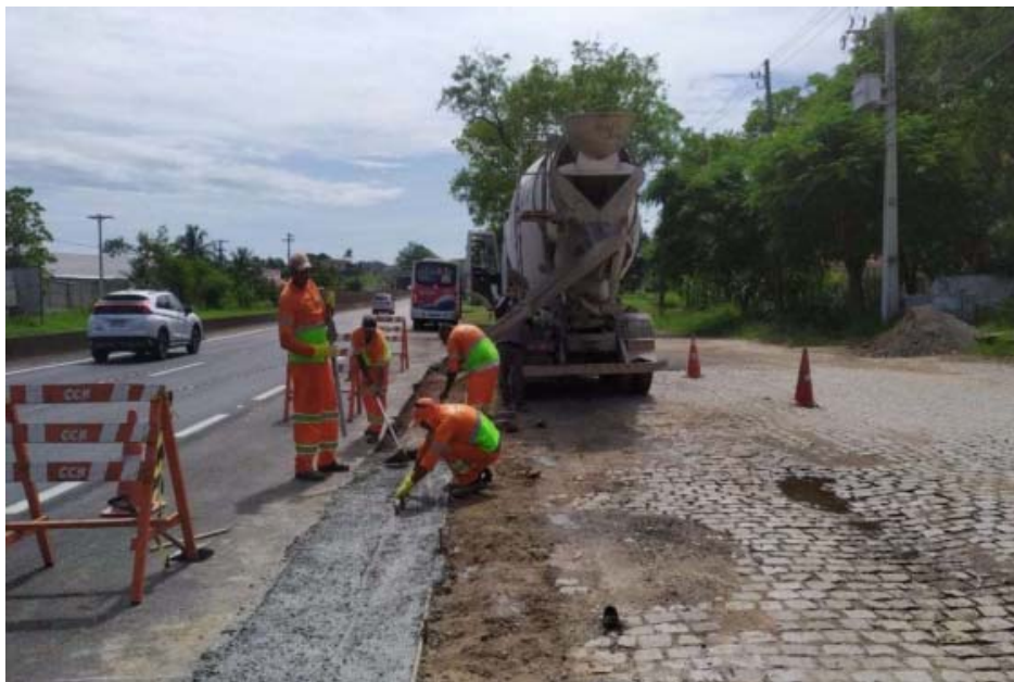
FOTO 10 - Reparo de Sarjeta – Km 13+700 Sul
