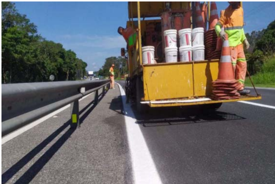
FOTO 04 - Pintura de Faixas – Km 21+000 Norte [2]
