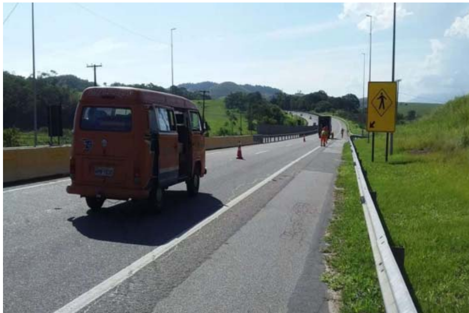
FOTO 06 - Implantação de Tachas – Km 24+00 Sul
