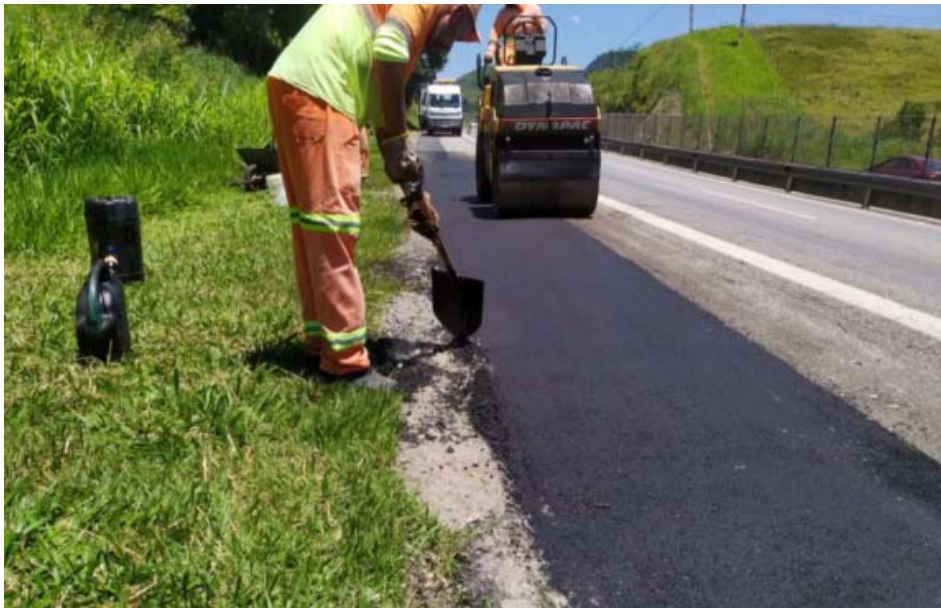
FOTO 02 - Rep. Superficial de Acostamento – Km 11+000 Sul
