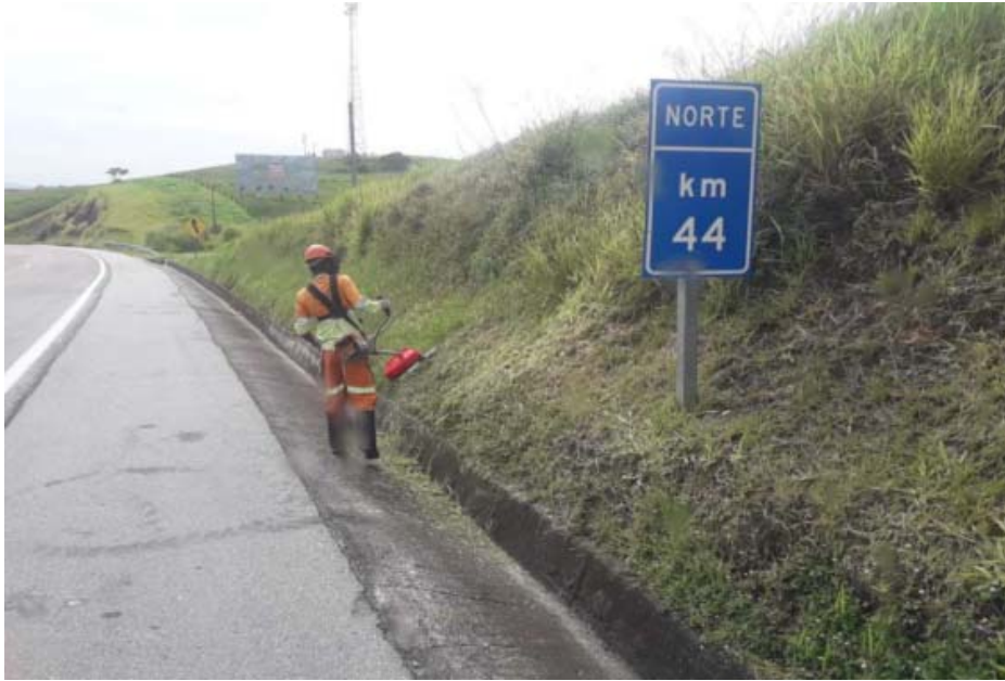
FOTO 11 - Roçada Manual – Km 44+000 Norte
