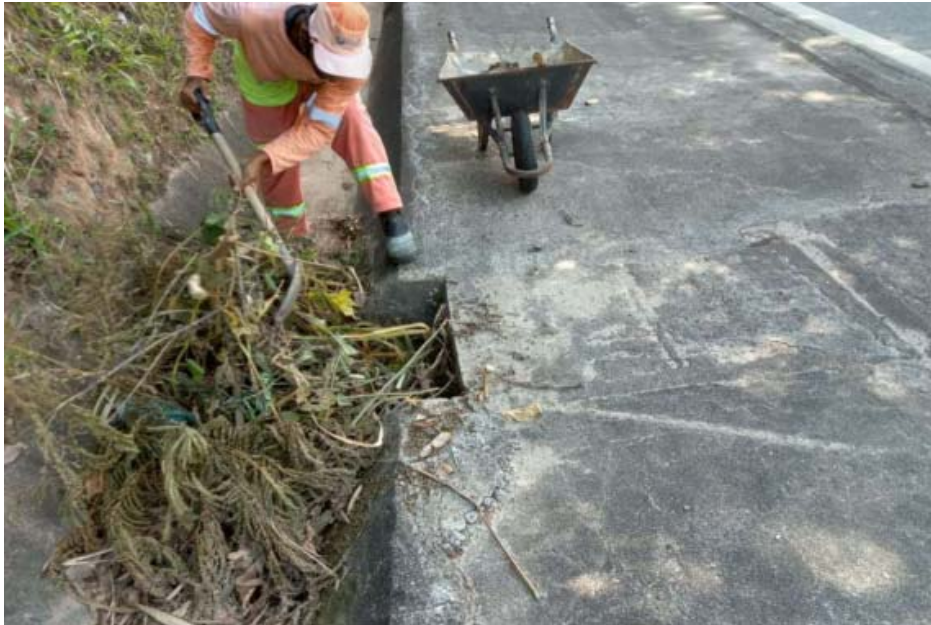
FOTO 09 - Limpeza de Valete de Corte – Km 01+000 Norte
