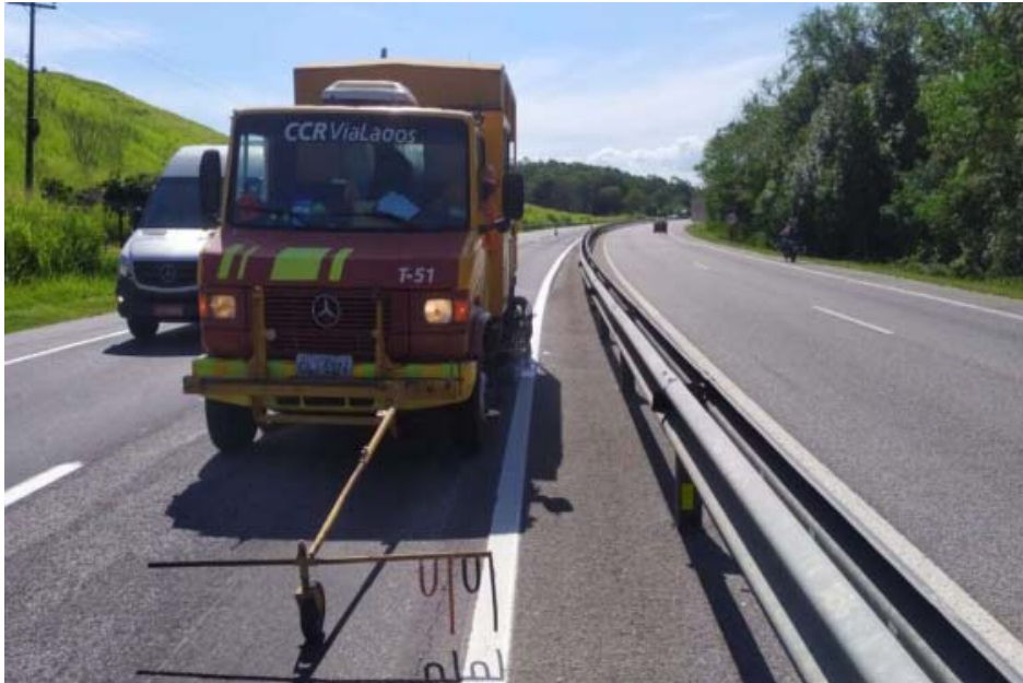
FOTO 03 - Pinturas de Faixas – Km 21+000 Norte [1]
